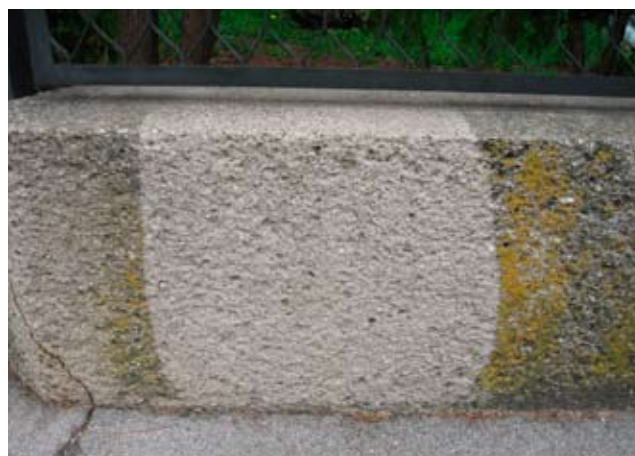
Vyčištění a nano-úprava schodu – test.
